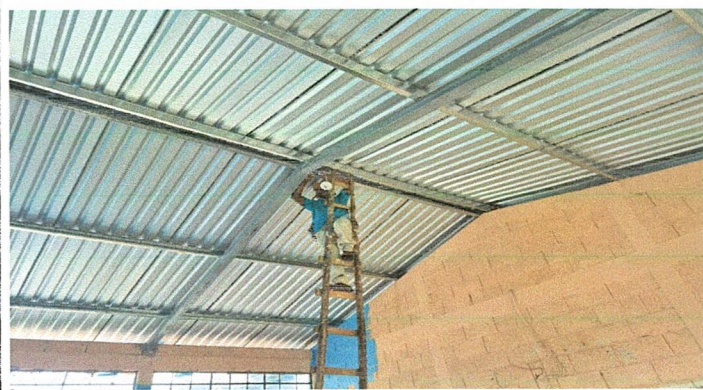
Foto 3: Se observa que se esta instalando la energia electrica en el modulo 1
