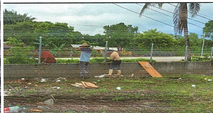
Foto 5: Se observa la sustitucion de la malla del muro perimetral
