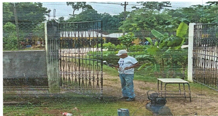
Foto 6: Se observa la sustitucion de pintura en el porton
