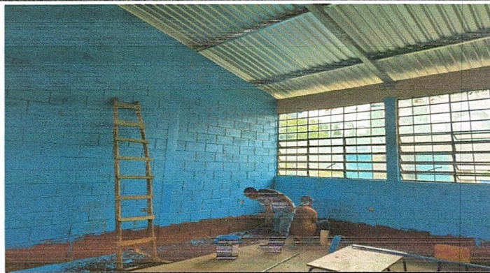
Foto 2: Se observa pintando las paredes del modulo 1
